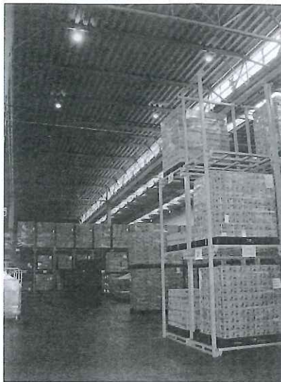
2階の天井高は20メートル
